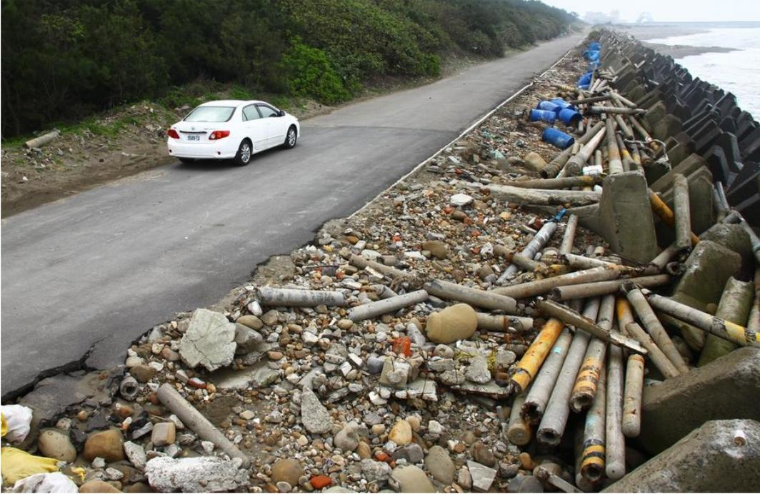
圖 9：因海岸倒退，利用廢棄電線杆消波，景觀雜亂。如果風浪太大，可能反被捲入海中，隨波逐流。
