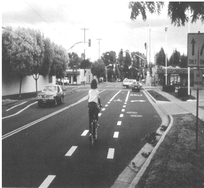
圖 4-7 腳踏車專用車道於路口左轉之設置方式
