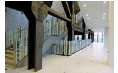
原有鋼骨融入新的空間當中，並以相同高度樓板連接不同年代空間，使其安全無虞。
