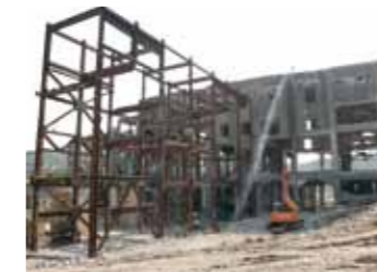
A棟拆除後留下的兩排鋼構，老結構重新包覆於新建築中，彷彿老骨頭重生長出了新血肉。
