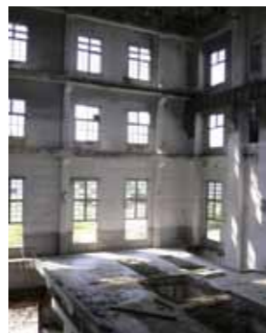
為一掃室內陰暗的採光，B棟牆面除結構外完全拆除。
