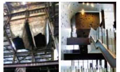
大廳內兩座昔日用來儲存未燃煤礦的漏煤槽，大器地由天花板垂直而下，其特異巨大的形體高懸挑空中，成為展廳的入口意象。
