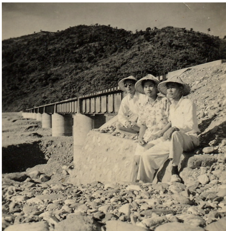
圖 3-5 臺東線鐵路馬太鞍溪橋
