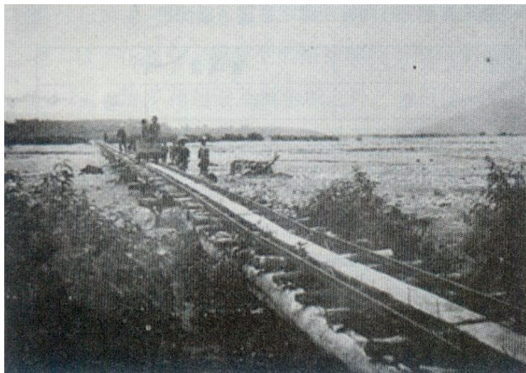
圖 3-2 臺東輕便鐵路馬太鞍溪橋
