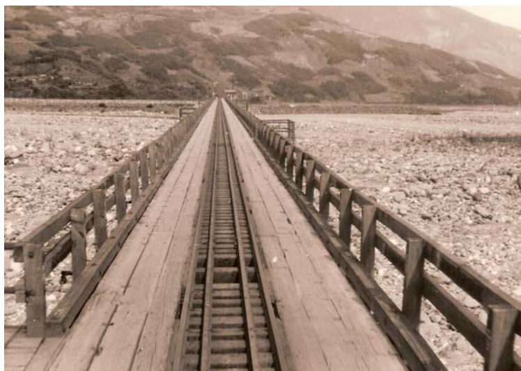
圖 3-8 臺東線鐵路馬太鞍溪橋（鐵公路兩用橋型式）
