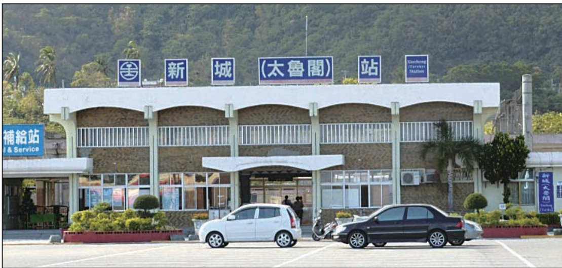
圖21 新城車站站前現況照片
