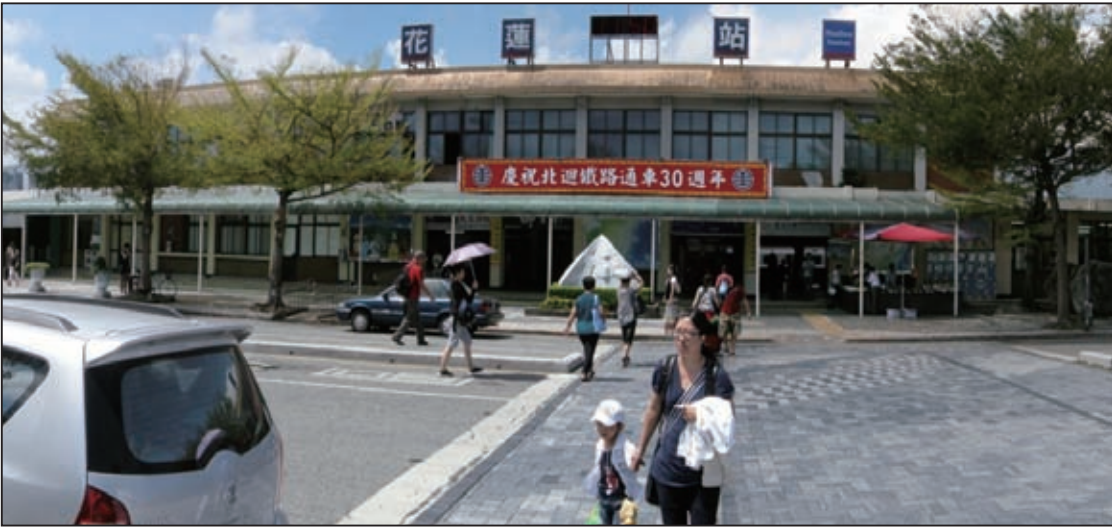
圖3 花蓮車站站前現況照片
