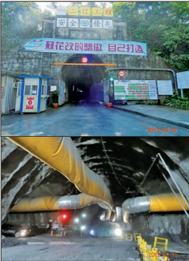
圖6 舊北迴鐵路隧道施工通行道路設置紅綠燈號誌管制
