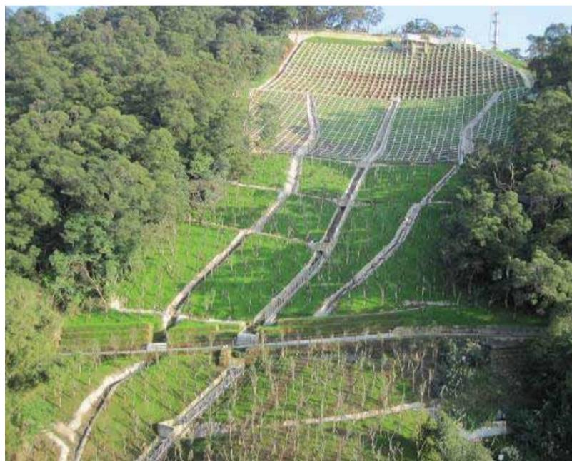
圖19 坡面植生及植栽完成圖 (99年1月)
