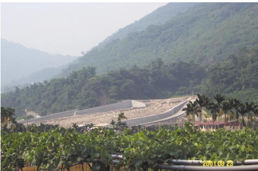
土石流潛勢區域整體工程防治配置系統（2） 沈砂池：配置於土石流危險溪流的下游處，目的在淤積大量土石於安全區域內，避免掩埋危害下游居民及農田。沈砂池必須在雨季來臨前清除堆積物，以提供淤積空間。
