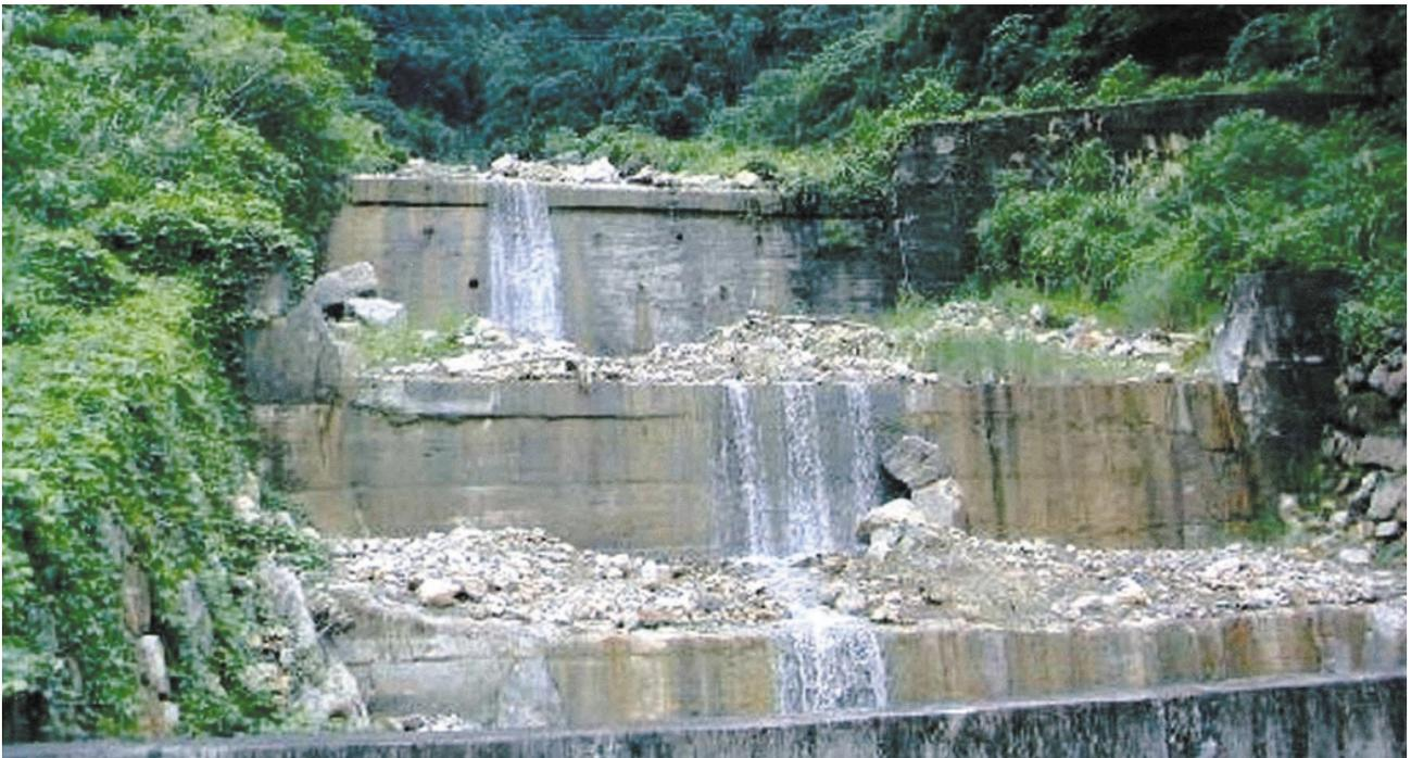
土石流潛勢區域整體工程防治配置系統（4）系列防砂壩：藉由一座以上串聯的防砂壩來攔阻上游崩場的土石，同時可達到避免河床向下刷深及保護兩側坡腳的目的。但此種完全封閉式的防砂壩有阻隔魚類等生態系統的缺點，因此較適用在旱季沒有水流的野溪。
