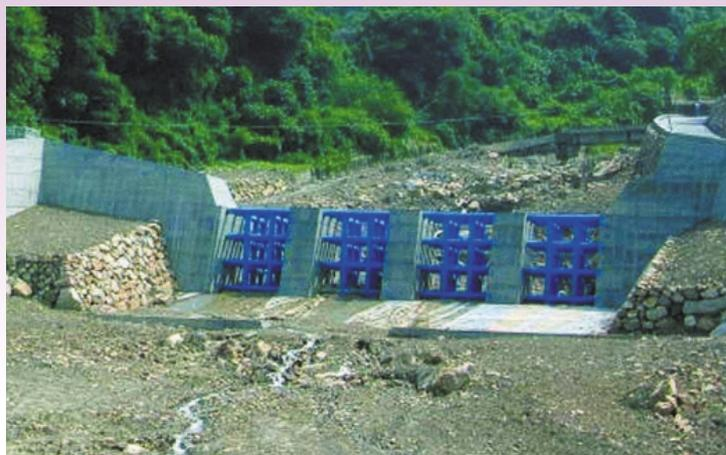
土石流潛勢區域整體工程防治配置系統（5） 格子壩：屬於透過性壩的一種，目的僅在於攔阻大塊石，讓小顆粒泥砂可以向下游流出，保持河川的泥砂輸送平衡，避免海岸線因缺乏土石流出而內移。
