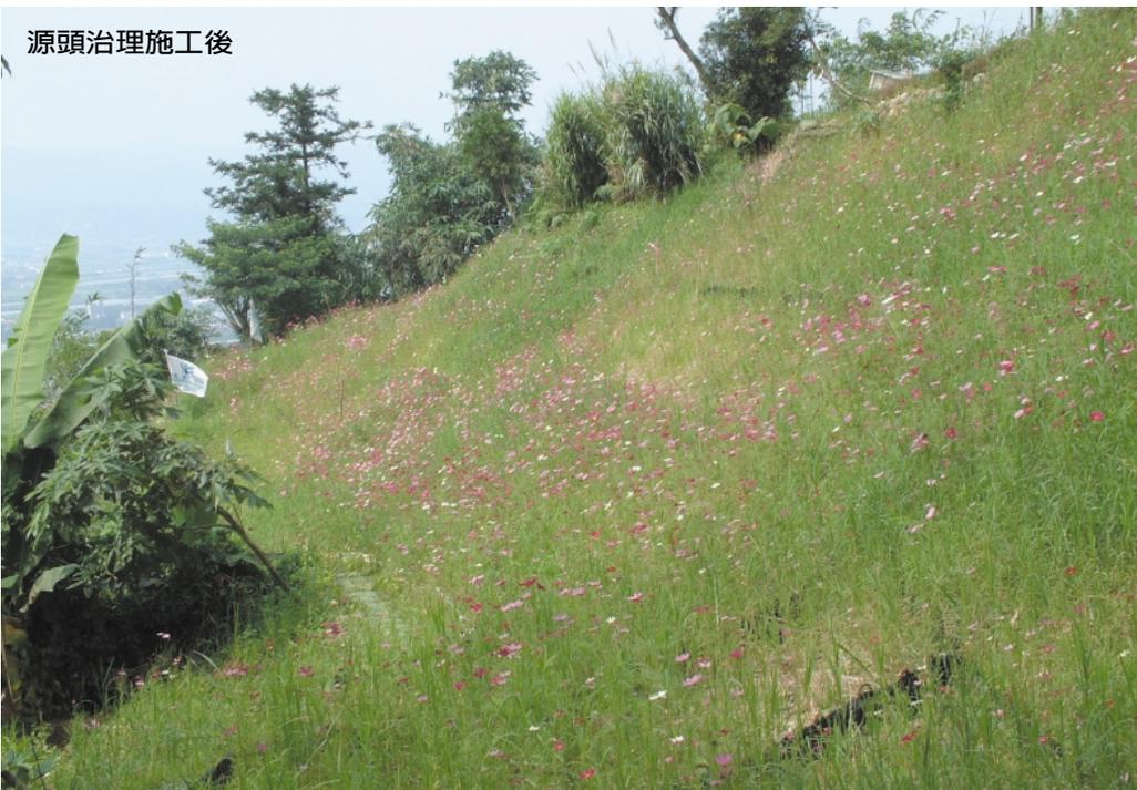
土石流源頭崩塌區域，提供土石流發生所需要的大量鬆散土石，因此須在雨季來臨前進行植生治理工程。藉由打樁編柵、鋪設草席並撒上草種的相關配合措施，幾個月後已是綠意盎然，滿山遍野的大波斯菊，除了達到防治土石流的目地外，也兼具美化的功效。
