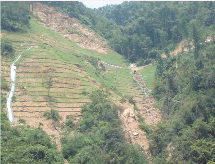
土石流潛勢區域整體工程防治配置系統（1） 打樁編柵：主要用於崩場地及土石流源頭的治理，目的在分散水流，穩定坡面，減緩土壤沖蝕，加速植生復育。
