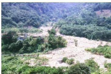
圖四 土石流疏導工法可使土石流延規劃安全路線流動
