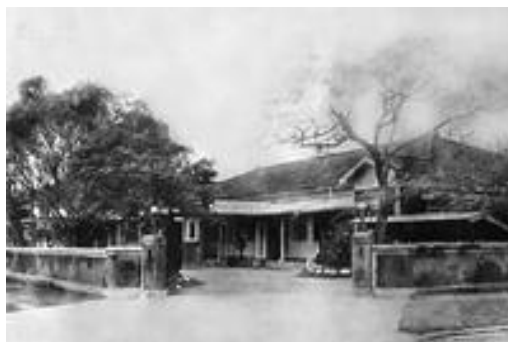
• 台中監獄署。照片位於今自由路的台中法院側門
