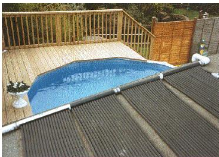
圖 3、應用於溫水游泳池之無面蓋 EPDM 式非金屬平板集熱器
