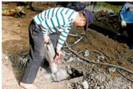
樹根上二層水泥一層瀝青，須動用大型電動擊子才能敲除，根還能生存嗎？
