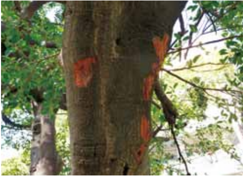
工程結束後，樹皮就損傷多處，也造成病原菌的入口。
