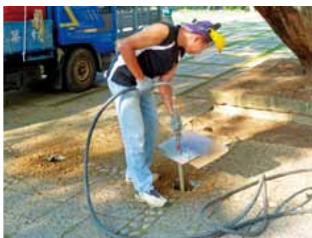
採用保根挖掘系統改良土壤。
