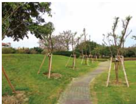
「三木支架」工程業界常用。
