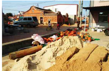
圖 4-9 工程進行時被堆滿施工的器具
