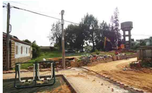
圖 4-11 工程的進行，怪手、推土機行徑下讓基地改變樣貌
