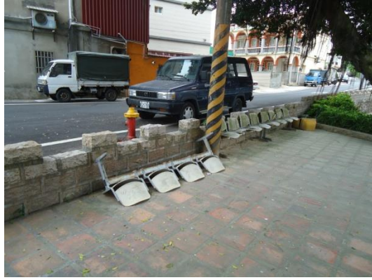
(2)回收裝設在公園的塑膠椅已破損、傾塌，而垃圾桶則無法給予居民使用。
