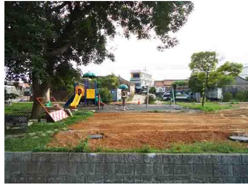
圖 4-13 施工後的運動公園
