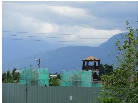
圖 2-11：文化祭祀廣場施工
