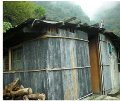
照片 5 居民 F3 西寶老家(鐵皮木板屋)
