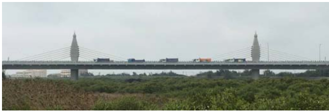
圖二 WH50-2 脊背橋靜態車輛載重試驗情形 (Case05)
