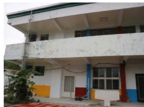
圖三 壽豐國小西側教室擴柱補強後無震損 (照片來源：杜怡章教授提供)
