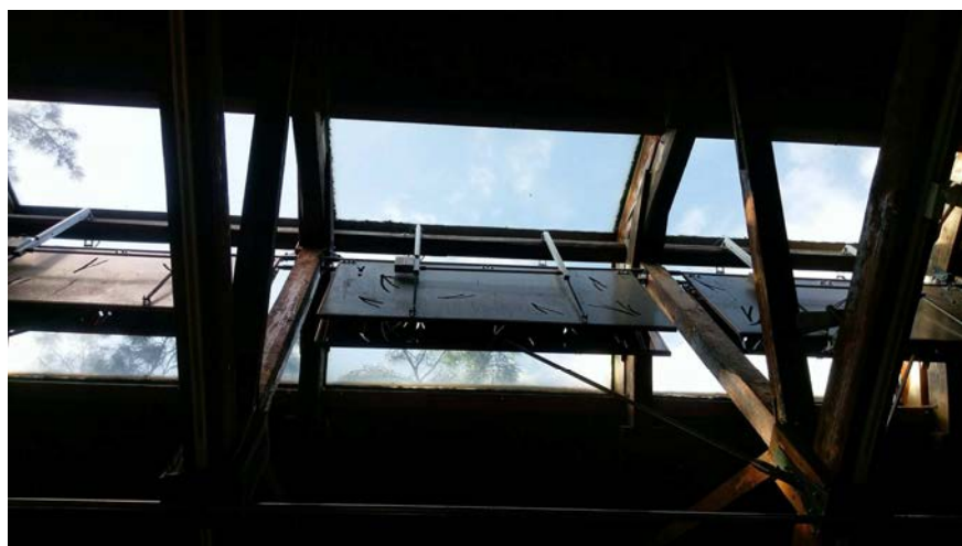
圖三：屋頂的透明屋頂及松針鐵板
