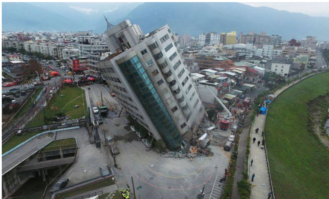
圖 5. 206 花蓮大地震傾斜的雲門翠堤大樓(圖片來源:花蓮電子報)
