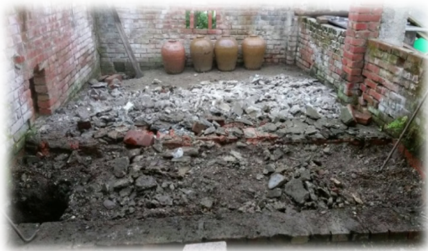
2017年4月23號建設中圖片
