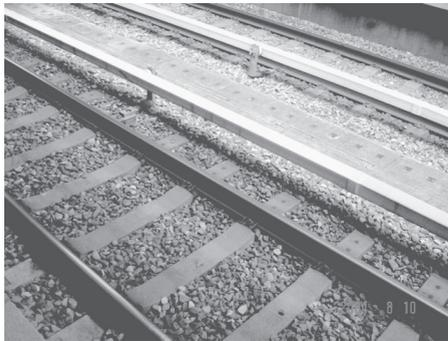
圖 3.3-8 以碎石構成的道床示意圖
