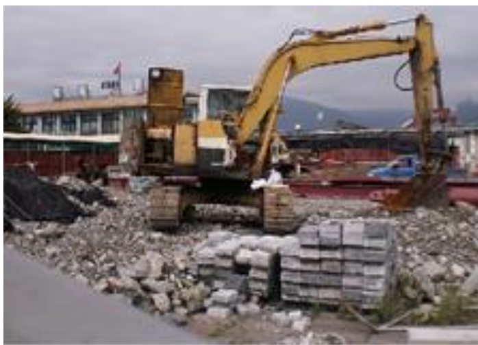
圖二、花蓮火車站施工現況
