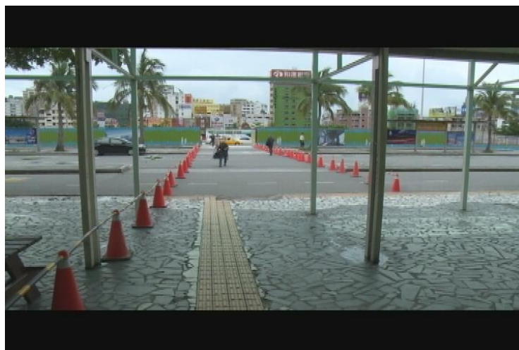
圖三、花蓮火車站前站之人行道圍籬 (引自 2016，客家電視)
