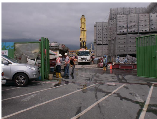
圖四、花蓮火車站工程狀況
