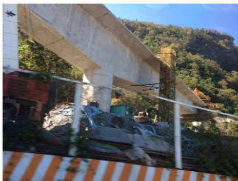
(圖八)蘇花改工程高架橋興建
