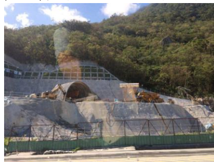
(圖七)中仁隧道興建工程進行
