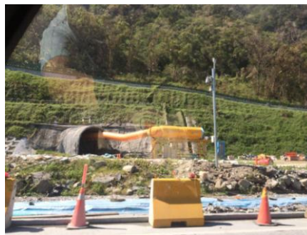
(圖五)仁水隧道興建工程進行
