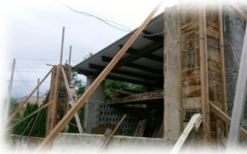
2017年3月26日建設中
